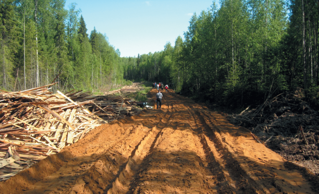
Рис. 39. Экспериментальный участок дороги в процессе строительства в июле 2009 г. Слева на фото – горбыль, который использовался для устройства основания
