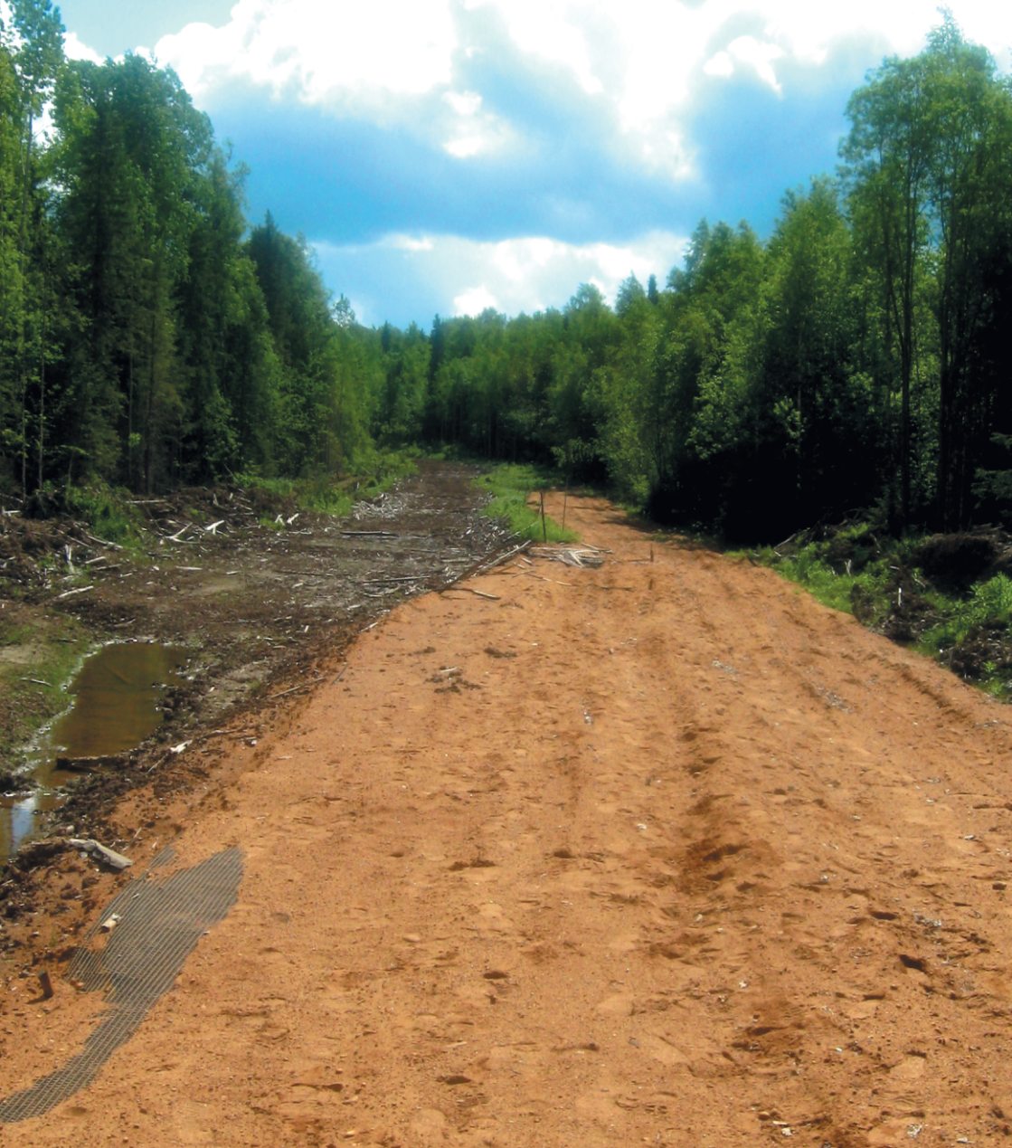
Рис. 41. Состояние построенного экспериментального участка дороги в июне 2010 г.
