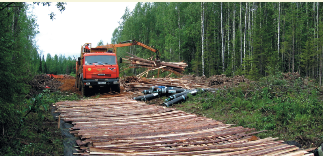
Рис. 24. Укладка горбыля в три слоя на геосетку
