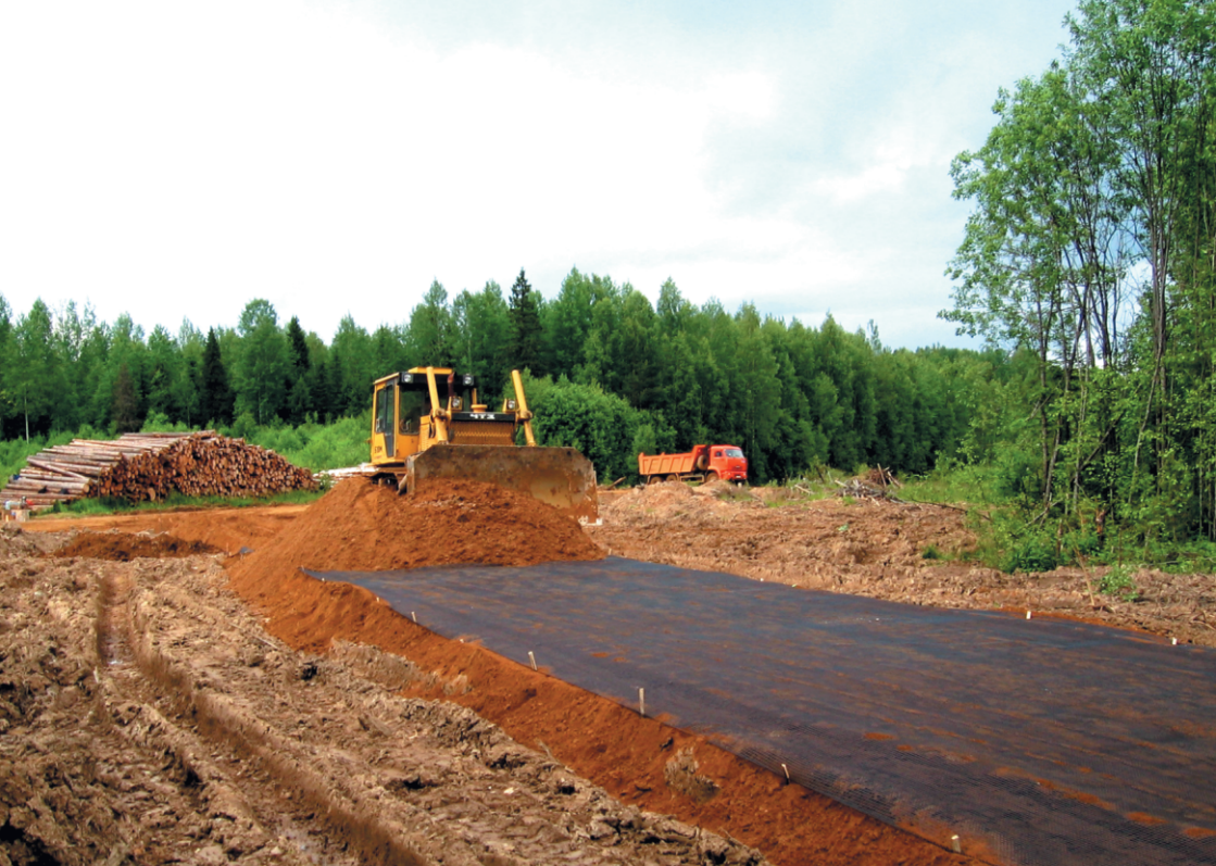
Рис. 21. Распределение песка бульдозером способом «от себя» по геосетке
