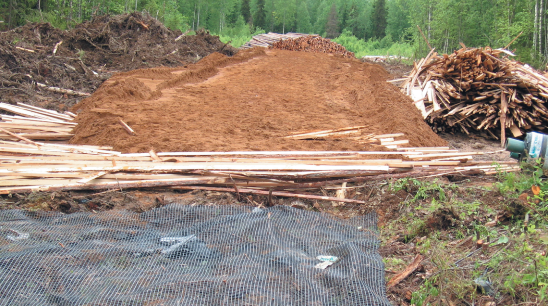
Рис. 25. Устройство дорожной одежды из песка
