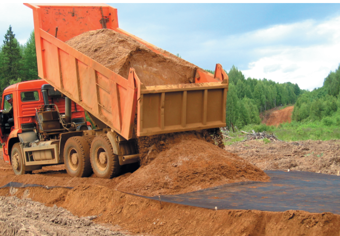
Рис. 20. Доставка и разгрузка песка на геосетку, уложенную на поверхность земляного полотна
