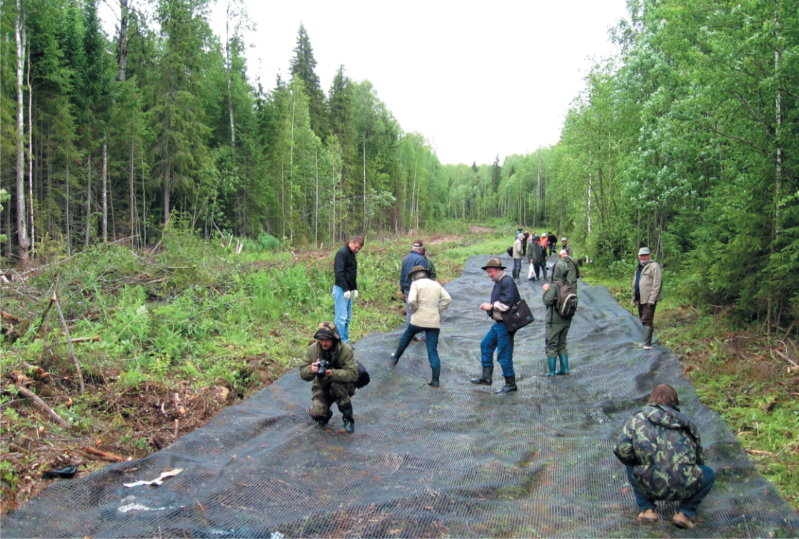
Рис. 23. Участок подготовленного основания дороги с геосеткой
