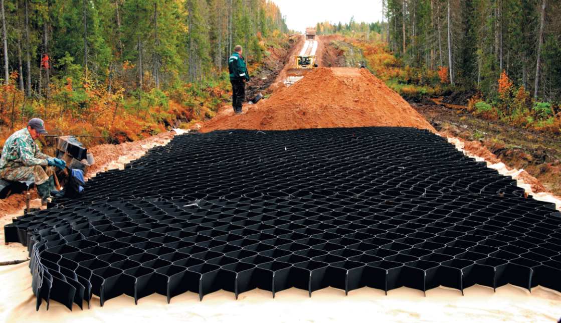
Рис. 27. Засыпка георешетки песчано-гравийной смесью (фото предоставлено фирмой «Славрос»)
